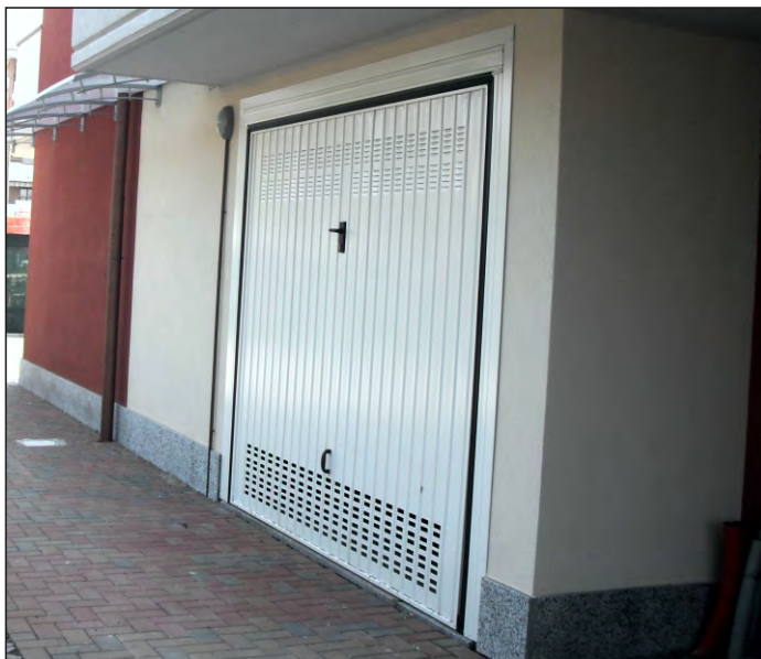
Esempio di basculante in lamiera installata nelle nostre precedenti realizzazioni.
