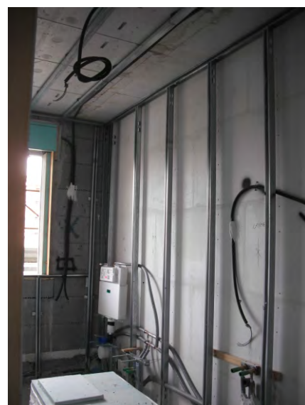
Particolare sistema Tecnoboard pareti interne
