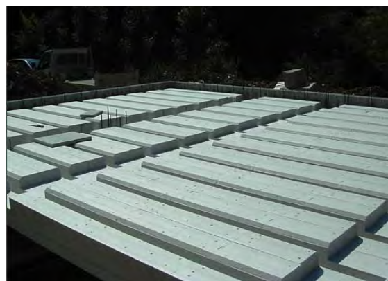
Foto con particolare sistema di posa Termosolaio della Argisol
