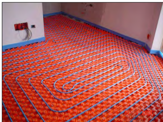
Realizzazione di riscaldamento a pavimento con pannelli bugnati in EPS e spire per il passaggio del fluido termovettore
