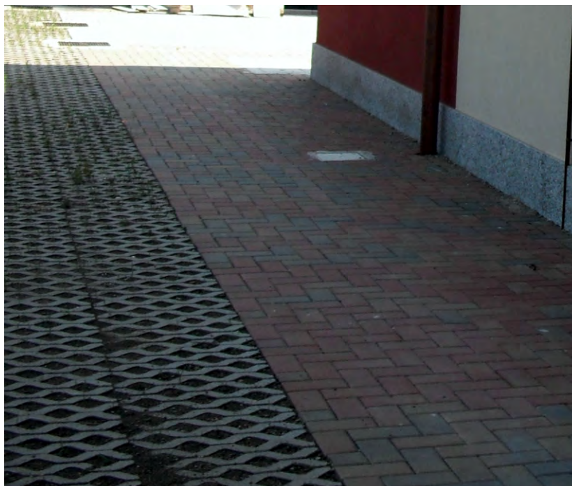
Esempio di pavimentazione in autobloccanti tre colori 10x20xH 8 cm e moduli prato armato in conglomerato cementizio prefabbricato
