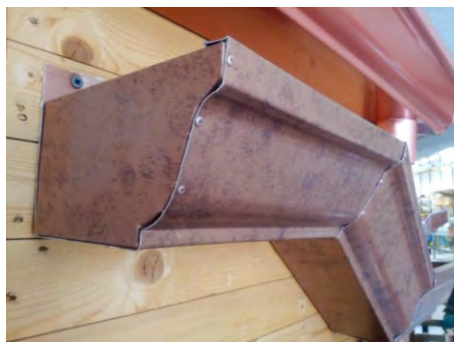
Esempio di lattonerie in alluminio effetto rame per scossaline, canali e pluviali
