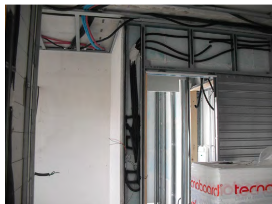
Particolare sistema contro soffittatura del solaio di copertura e passaggio impianti interni
