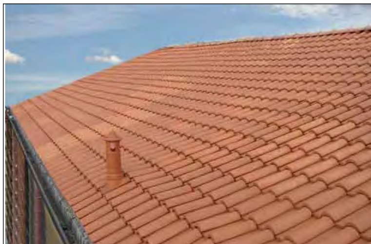
Particolare copertura in tegole portoghesi ed esalatore servizi igienici
