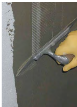
Rasatura di facciata in doppia mano con rete in fibra di vetro alta grammatura
