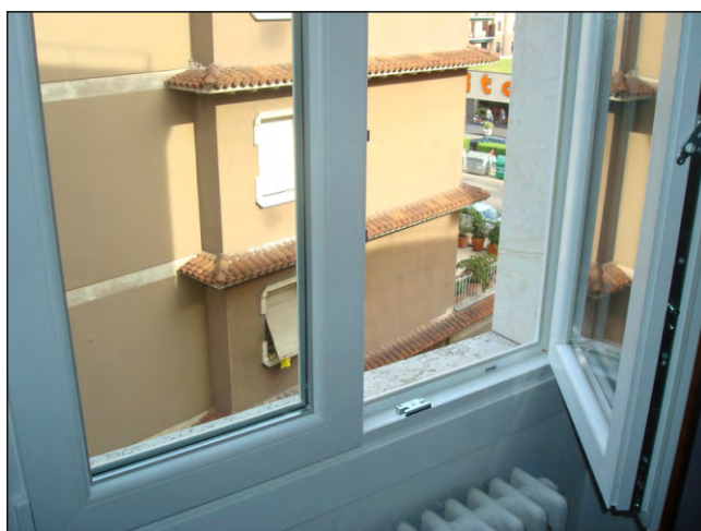
Esempio di serramento in PVC cinque camere bianco in pasta, doppia guarnizione
